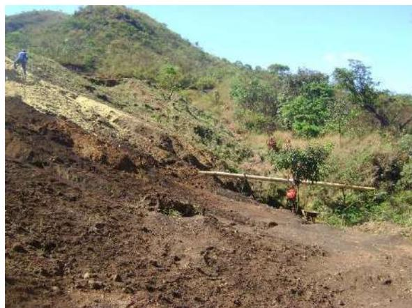
**Foto 5.4** – Limpeza da face do talude e lançamento de camada de areia.
