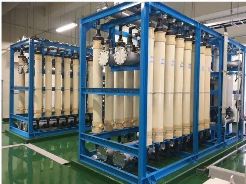
**Figura 4 – Exemplo de “Skid” de módulos de membrana**
