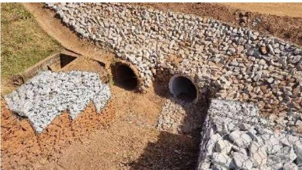
**Foto 5.31** – Vista da descida em degraus, bacia de dissipação e bueiros
