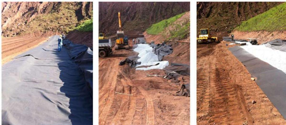
**Figura 5.5** – Construção do dreno coletor.
