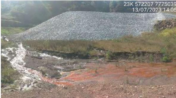
**Foto 5.19** – Enrocamento de reforço a jusante da barragem.
