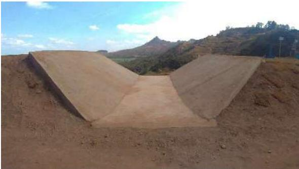
**Foto 5.29** – Emboque do sistema extravasor.
