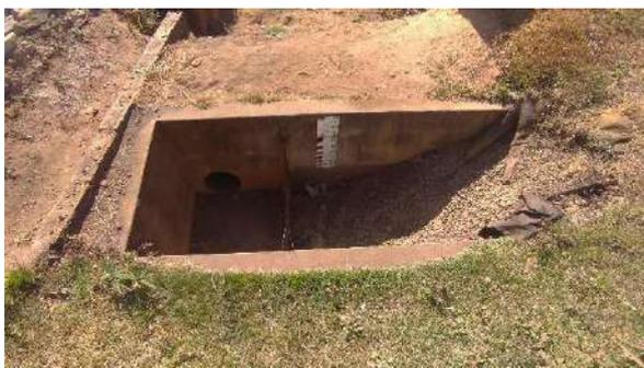
**Foto 5.16** – Detalhe da saída da drenagem interna do 2º alteamento.
