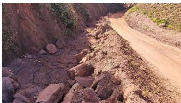
**Foto 5.26** – Descida d'água da ombreira direita (trecho escavado em terreno natural).
