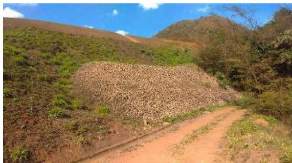
**Foto 5.17** – Dreno invertido instalado em 2009 para tratar surgência.
