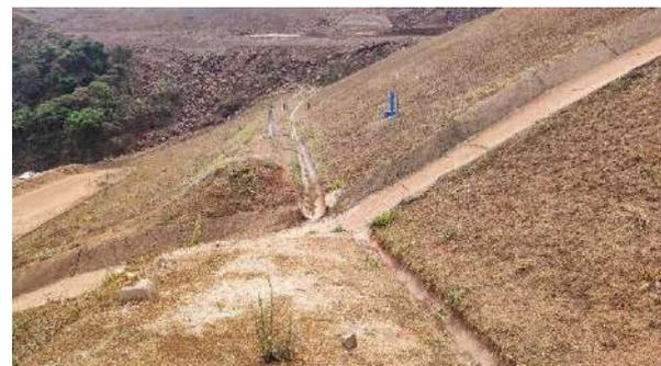
**Foto 5.22** – Saída da canaleta da berma do 2º alteamento no canal do extravasor.
