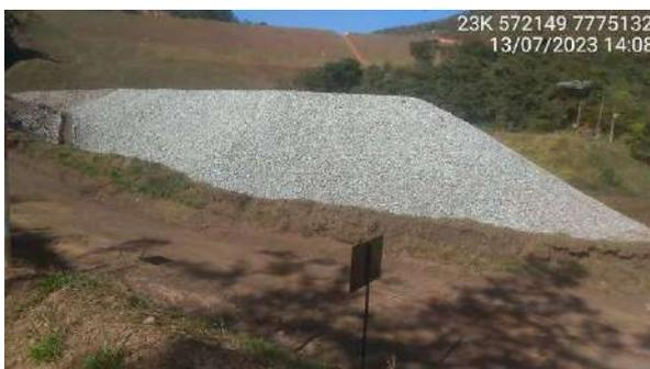
**Foto 5.11** – Vista do aterro de reforço e dos taludes de jusante.
