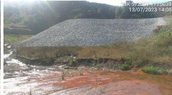
**Foto 5.14** – Detalhe do talude do reforço em enrocamento.
