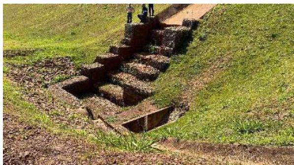
**Foto 5.15** – Vista da saída da drenagem interna ao lado da bacia de dissipação do extravasor.
