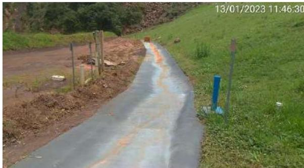
**Foto 5.23** – Trecho com revestimento em manta cimentícia e em pedras de mão.
