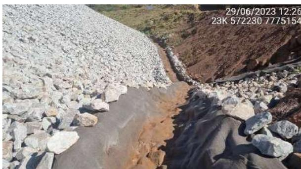
**Foto 5.27** – Drenagem superficial no contorno da ombreira direita do reforço de enrocamento.
