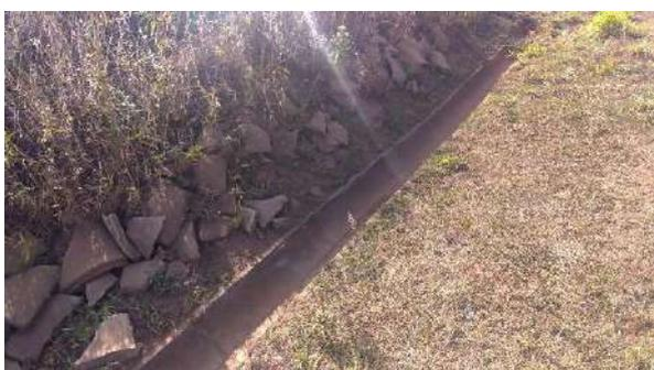
**Foto 5.25** – Descida d'água da ombreira direita (trecho em canaleta meia cana).
