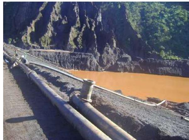
**Foto 5.10** – Detalhe dos espigotes instalados na crista do dique auxiliar. (janeiro/2011).
