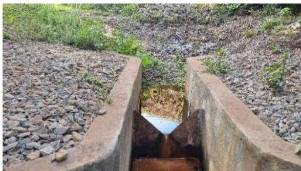
**Foto 5.18** – Saída da drenagem interna da barragem (IV-01).
