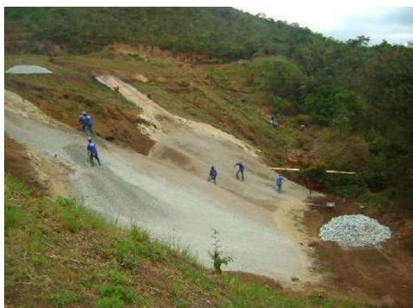
**Foto 5.5** – Lançamento da camada de brita do dreno invertido.
