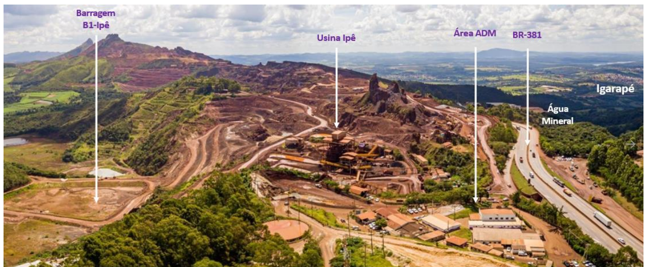
Figura 6-2 – Vista para o empreendimento Mina Ipê. Fonte: MMI, 2024.
