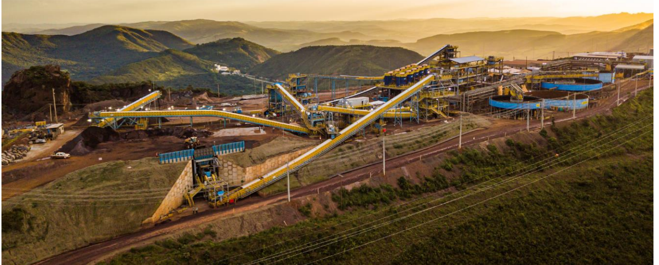
Figura 6-1 – Nova usina de beneficiamento de minério da Mina Tico-Tico – Projeto Morro do Ipê 6 MTPA. Fonte: Relatório de Sustentabilidade MMI, 2023.
